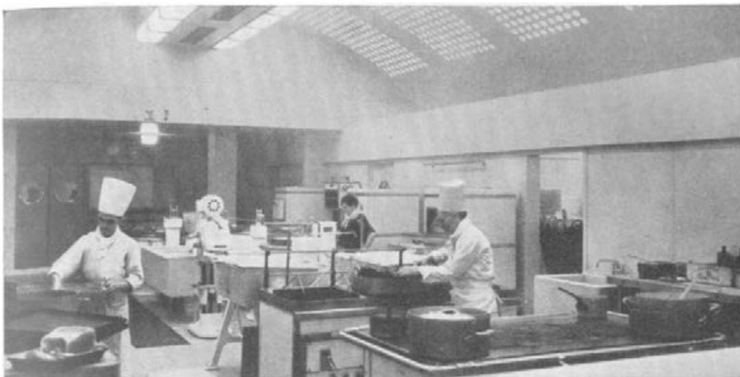
Cuisine du réfectoire du personnel de la Compagnie Parisienne de Distribution d'Electricité. Tous les appareils fonctionnent à l'électricité : on voit le fourneau, les friteuses, les bacs mélangeurs, les fours, une salamandre. (Phot. C.P.D.E.)
