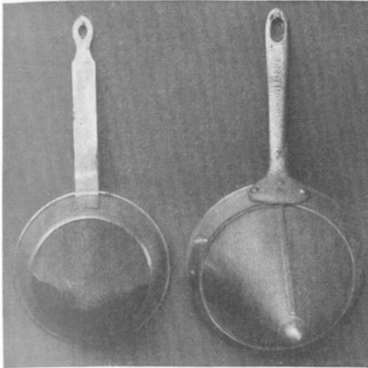
Chinois en toile métallique et en tôle percée de trous.
